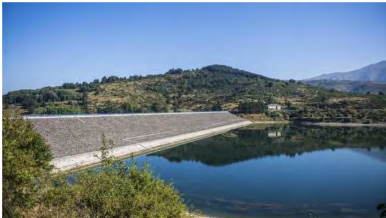
Diga di Poggio Cancelli – Campotosto (Aq).
