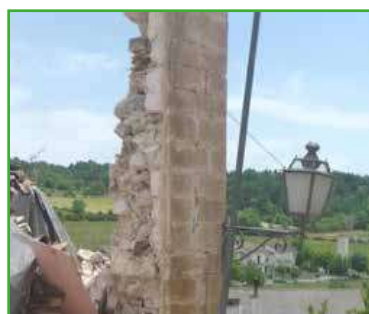
Figura 13. Rivestimento in lastre di pietra su un'apparecchiatura scadente.
