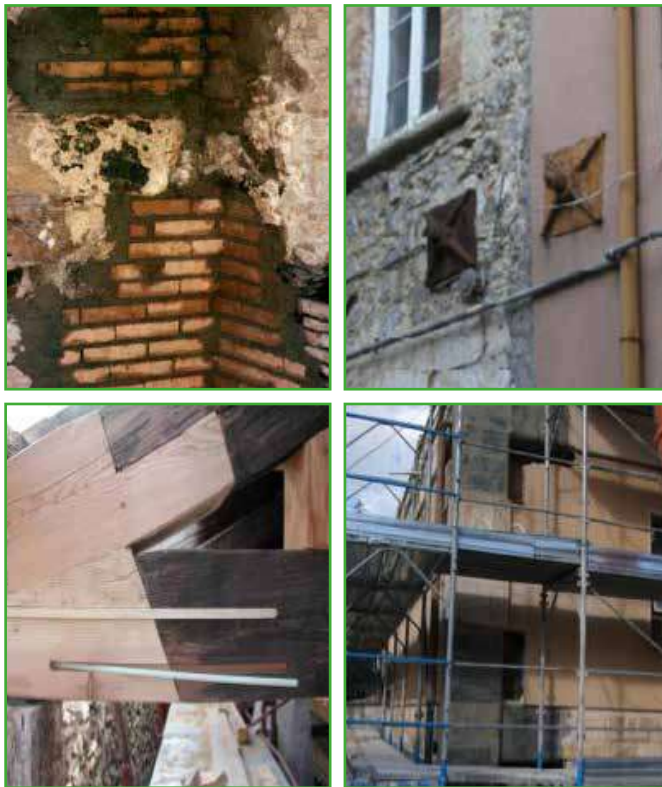
Figura 19. Esempi di intervento (cuci e scuci; capichieve a piastra, rinforzo trave lignea, e fasciature mediante fibre di carbonio) (DPC – ReLUIS, 2011).
