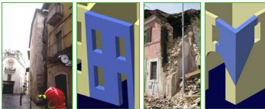
Figura 6. Esempi di meccanismi di collasso: ribaltamento integrale della facciata (sinistra); collasso dell'angolata (destra) (DPC-ReLUIIS, 2011).
