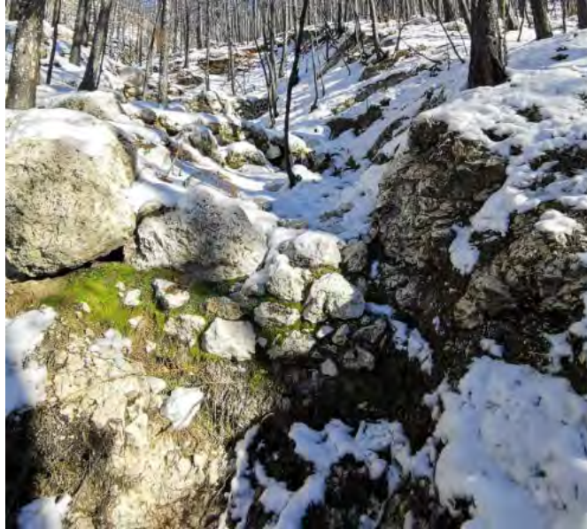
Figura 66 – Briglia danneggiata osservata durante il rilevamento
